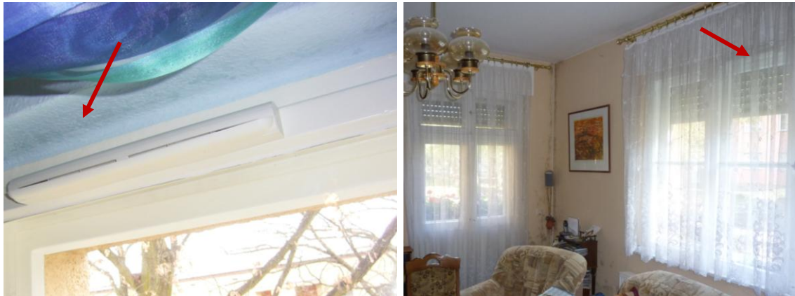
Abb. 3: a) Raumklimatisch bedingte Schimmelpilzbildungen (s. Pfeil) im Sturzbereich oberhalb eines Außenluftdurchlasses einer Abluftanlage infolge unterlassenen Betriebs des im Brüstungsbereich vorhandenen Heizkörpers (links); b) raumklimatisch bedingte Schimmelpilzbildungen in einer Wohnung mit Kastenfenstern ohne Falzdichtungen und zusätzlicher Abluftanlage (rechts; ALD im oberen Fensterbereich; s. Pfeil)
